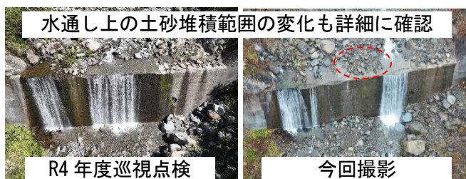
写真2 点検撮影(別当谷砂防堰堤群内)
