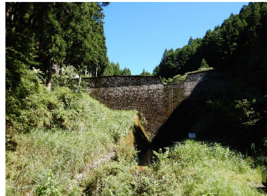
写真 1 井出谷堰堤の状況
