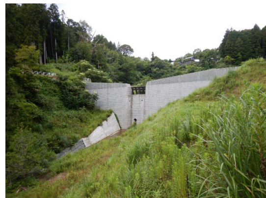
写真 2 室生口堰堤の状況
