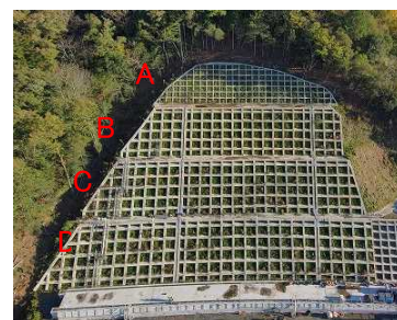
写真-1 計測対象法枠全景
