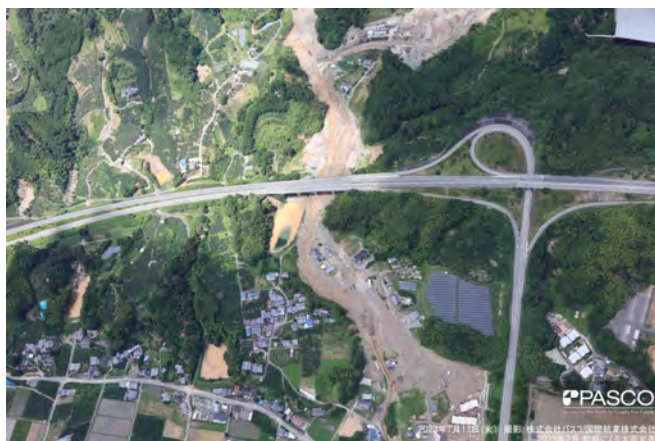
図 1 寒水川氾濫状況 (2023 年 7 月 11 日撮影)
