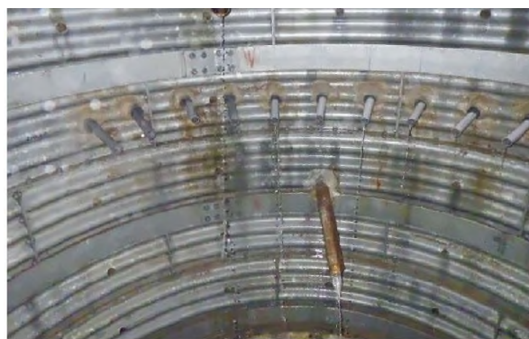
写真 4.2 6号集水施工集水状況
