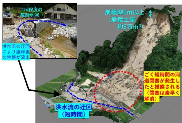
図-1 小原地区大規模崩壊
