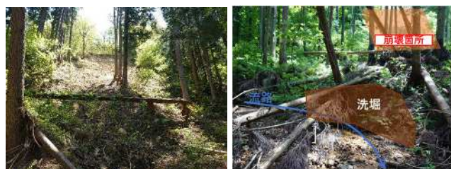
a) 崩壊斜面
