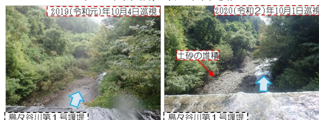
図-7 島々谷川第1号砂防堰堤の直下流の状況 (左:出水前, 右:出水後)
