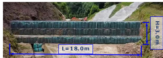
図7 応急土石流ガードの捕捉前状況
