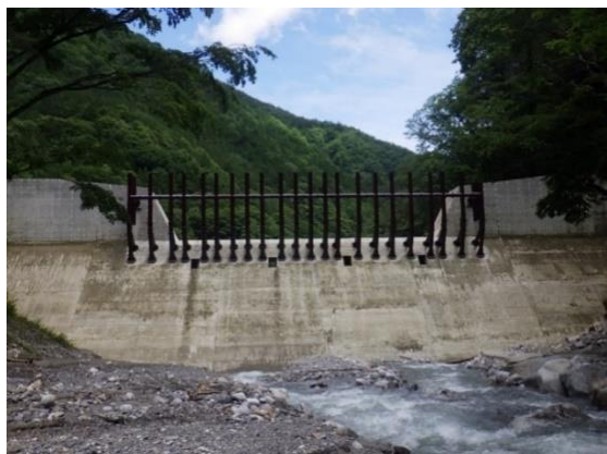
図4 黒川第4砂防堰堤の捕捉前状況写真
