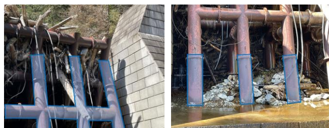
(a) 越流落下礫の衝突が想定される部材 (b) 底版近傍部材
