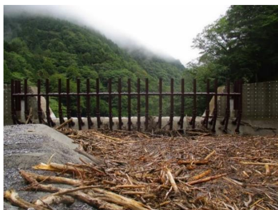
図5 黒川第4砂防堰堤の捕捉後状況写真
