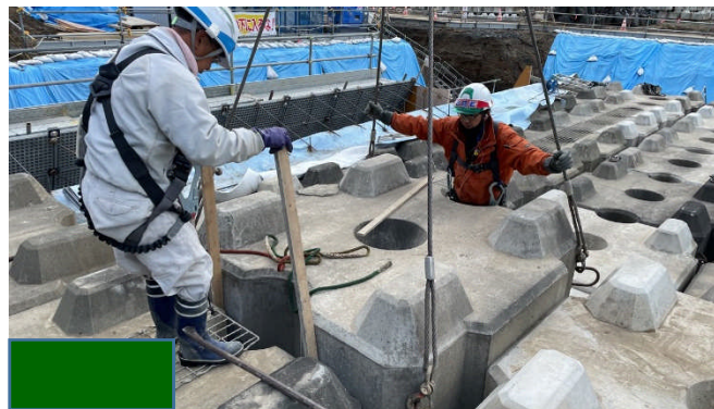
図8 施工状況（ブロックの設置）
