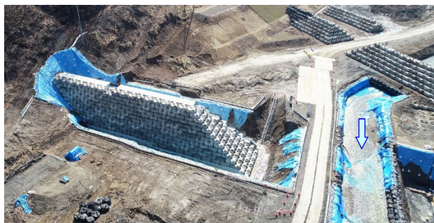
図7 本堰堤の施工状況（令和5年3月時点）
