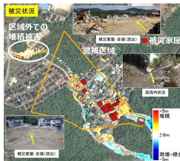
図1 川角の被災状況(広島県の資料 5) に加筆)
