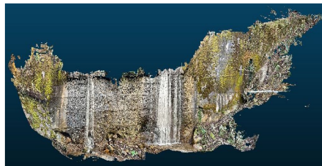
図-2 堰堤正面の点群画像
