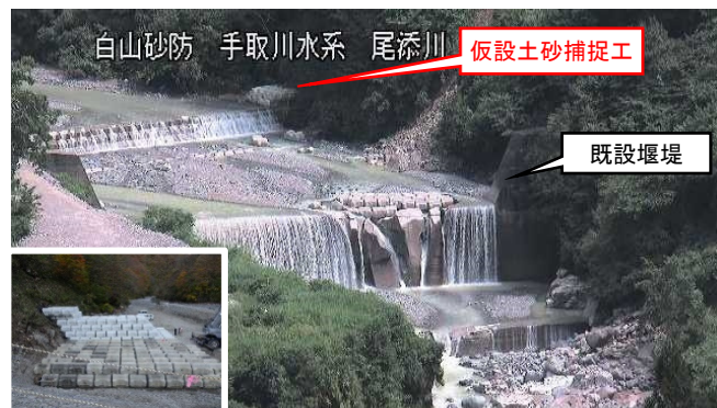
図-4 仮設土砂捕捉工状況（令和4年8月19日）
