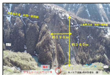
図-2 斜面崩壊概要 3)
