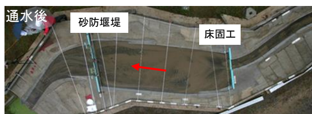
写真1 遊砂地の土砂捕捉状況
