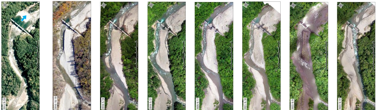
図 4.1 戸蔦別川第 5 号砂防堰堤堆砂敷オルソ画像比較
