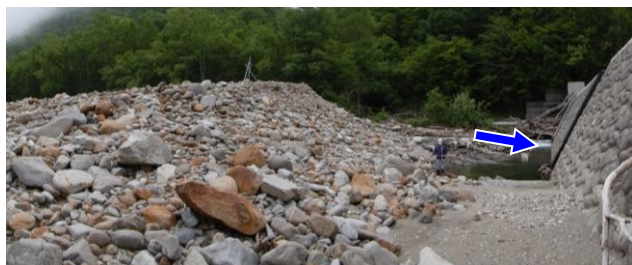
図 1.2 戸蔦別川第 5 号砂防堰堤の堆砂肩の状況
