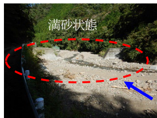
図-2 八重沢砂防堰堤の堆砂数の状況
