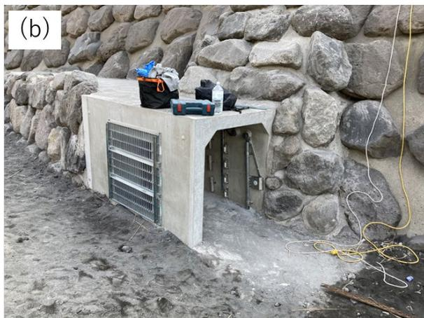
図-1 観測用ボックスカルバートの (a) 設置図および (b) 概観
