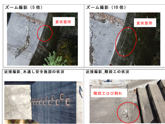
図-3 施設変状の詳細把握（ズーム撮影・近接撮影）
