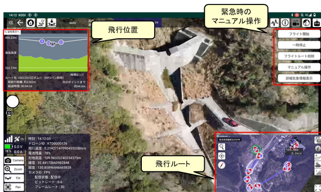
図-4 宮園地区における全自動飛行による施設点検状況
