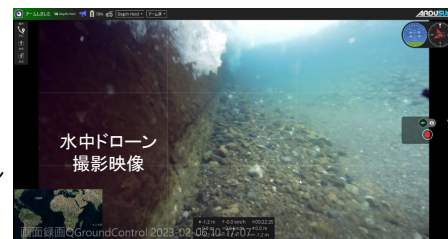
図-5 水中ドローンによる洗掘調査の状況
