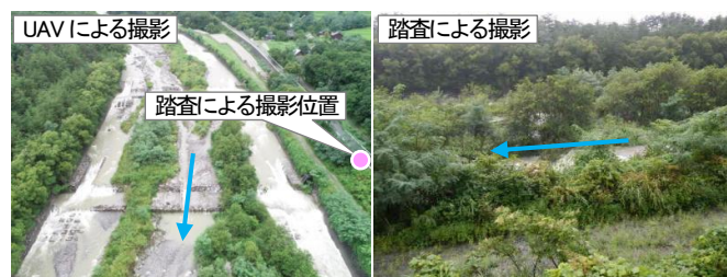
図 2 踏査撮影と UAV 撮影の比較 (大武川第 15 床固の例)
