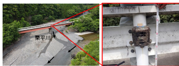
図3 インターバルカメラの設置状況
