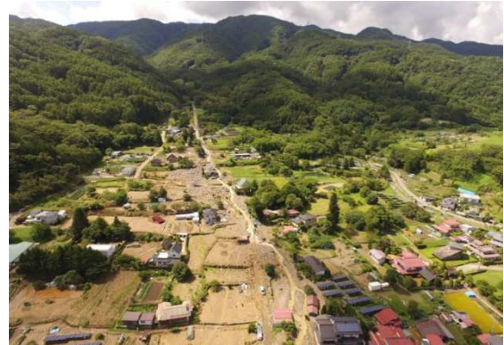
写真-1 被害状況 (令和3年9月6日撮影)
