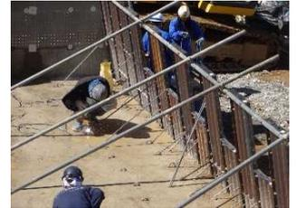
写真3 壁面材の組立状況
