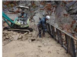
写真2 壁面端部の締固め状況
