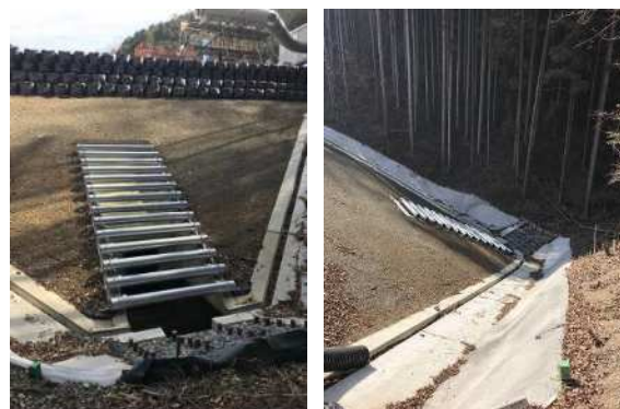
写真-1 施工された道路盛土における土石流対策工の設置状況
