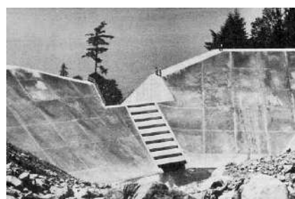
写真-1 渓流に設置された盛土形式の土石流対策工の外観 (カナダ；チャールズ・クリーク) 5)
