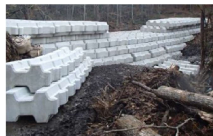
図3 御嶽山の緊急対策工の施工事例
