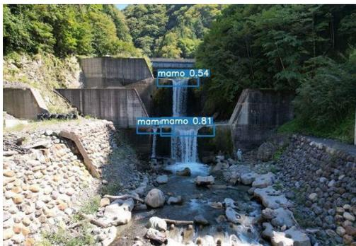
図-3 物体検出による摩耗変状抽出結果（黒川下流砂防堰堤）
