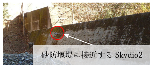
図.2 現地調査状況（Skydio2）
