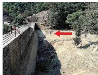
写真-2 土砂撤去後（鳥越1号砂防堰堤）
