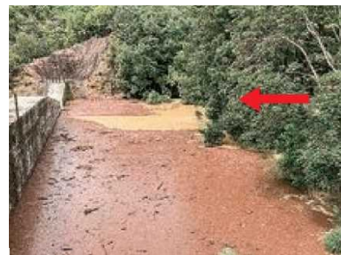
写真-1 土砂捕捉直後（鳥越1号砂防堰堤）
