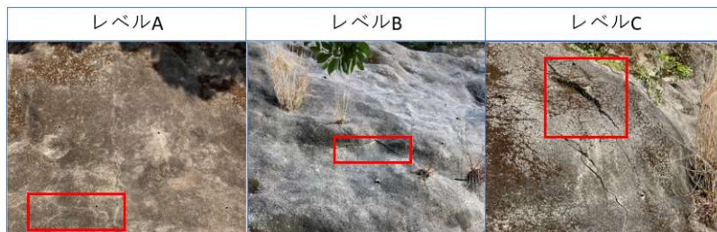
図-3 ひび幅のレベル別の画像（離隔距離 5m）
