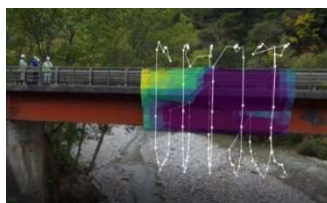
図3 障害物を回避しながら自動飛行
