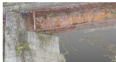
図4 三次元点群データ (小日砂防堰堤と小日橋の接合部)
