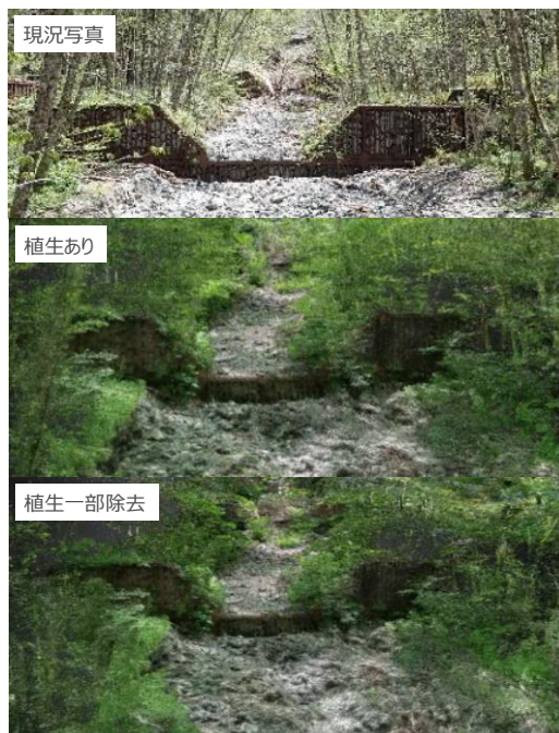
図 5 色付点群データ(溪床状況)
