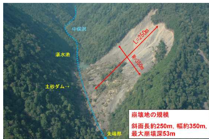
図-1 形成直後の土砂ダム（2011 年 9 月撮影）
