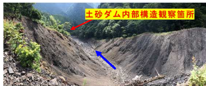
図-2 越流決壊後の土砂ダム（2020 年 7 月，上流より撮影）
