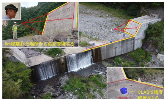
図-6 砂防堰堤の形状の取得状況
