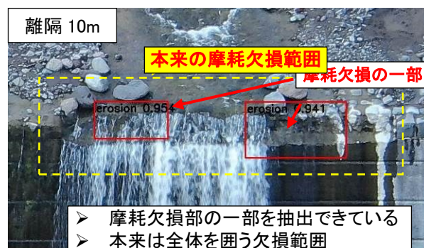
図-5 離隔10mのAI検出結果(欠損部の分割検出)
