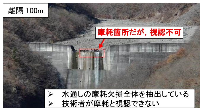
図-2 離隔100mのAI検出結果(検出可だが根拠不明)
