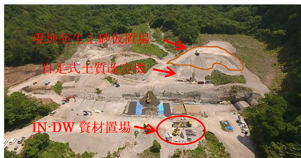
図 3 5 月本堤施工開始
