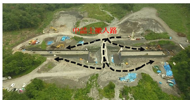
図 4 7 月施工状況(H=6.6m,V=5,200m 3 )
