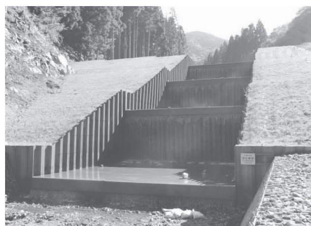
図-4 矩形化した多段落差工の施工事例
