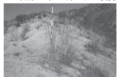
写真-8 侵食が続いている
