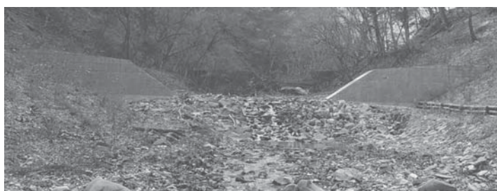
写真1 茂倉沢に設置されたNo. 5-2ダム
