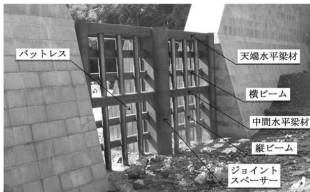
写真-1 堰堤構造システム
