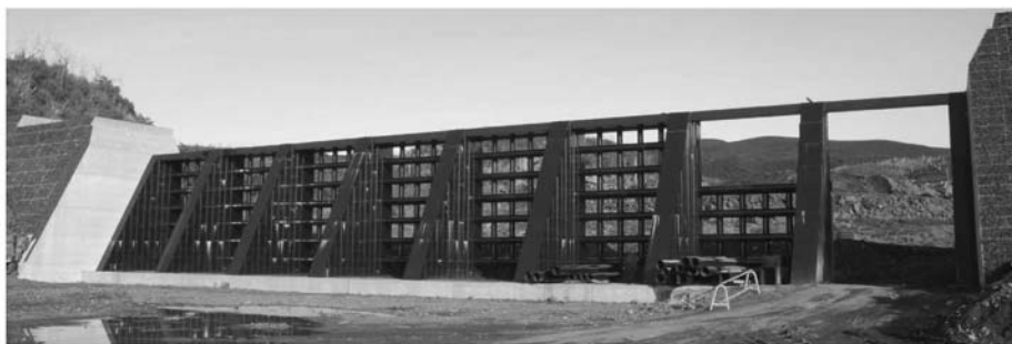
写真-6 多径間機能部材取外し例 (鉄砲夕景沢3号堰堤：東京都三宅支庁)
