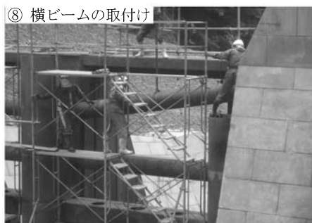
写真-4 機能部材脱着状況
