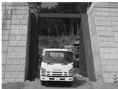
写真-5 透過部重機往来例 (清水川支川堰堤：秋田県由利地域振興局)
