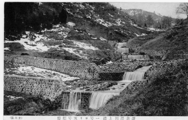
図-1 鎌倉沢川第一号堰堤(昭和11年撮影, 南魚沼市所蔵) 2)
