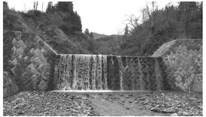
図-5 石積による復旧（鎌倉沢川第七号堰堤）
