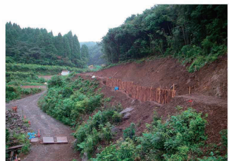
写真-3 1号擁壁の全景
