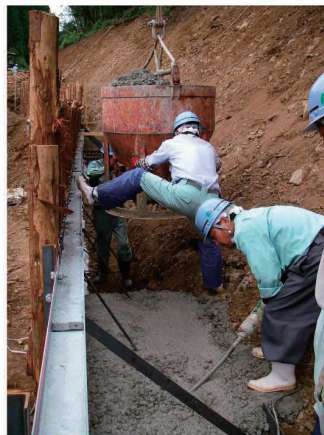
写真-2 底部コンクリート打設
