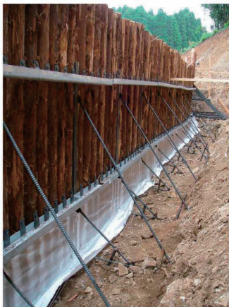
写真-1 組立て状況
