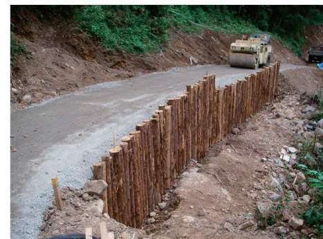
写真-4 2号擁壁の全景
