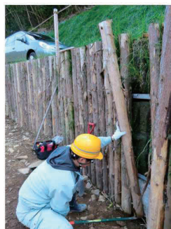
写真-5 間伐材取外し
