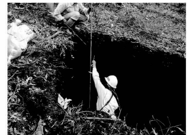
写真-1 試掘の状況
