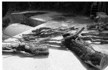
写真4. 砂防えん堤に流出してきた流木
