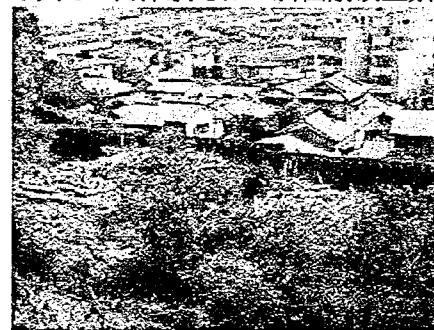
写真4 崩壊末端部の状況
