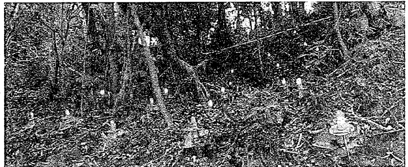
写真 2 対象斜面に施工されたノンフレーム工法
