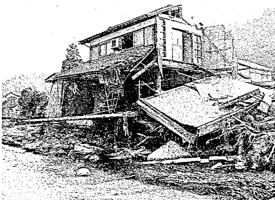
写真6.一乗谷川被害状況②
