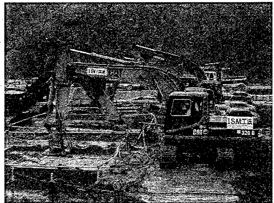
写真-1 ISM工法施工状況
