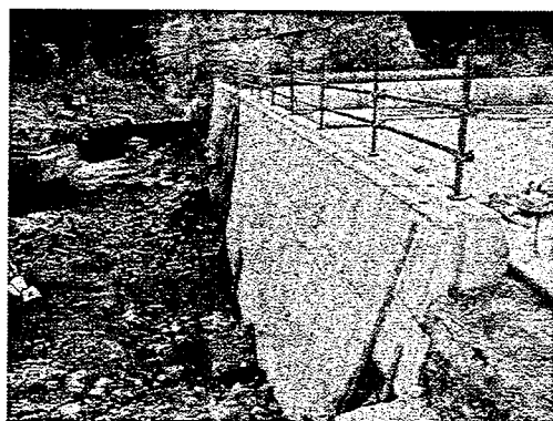
写真-4 大型コンクリートブロックによる施工状況
