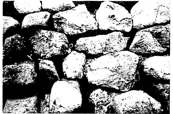
写真-2 T-CSG工法による巨石積み護岸
