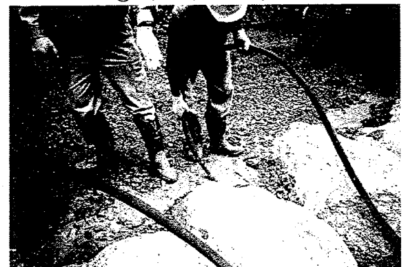
③バイブレータによる締固め
