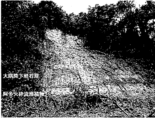
写真-1 新御堂(上ノ宮)地区の表層崩壊
