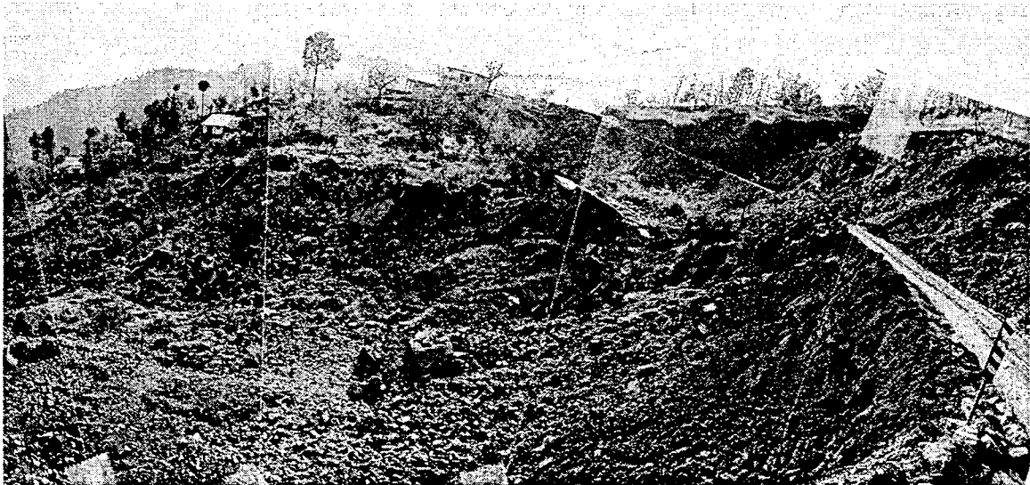
写真一 地すべりによる道路崩落箇所
